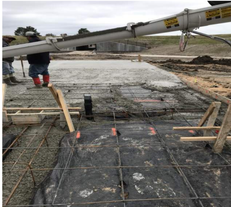
Stage slab pour
