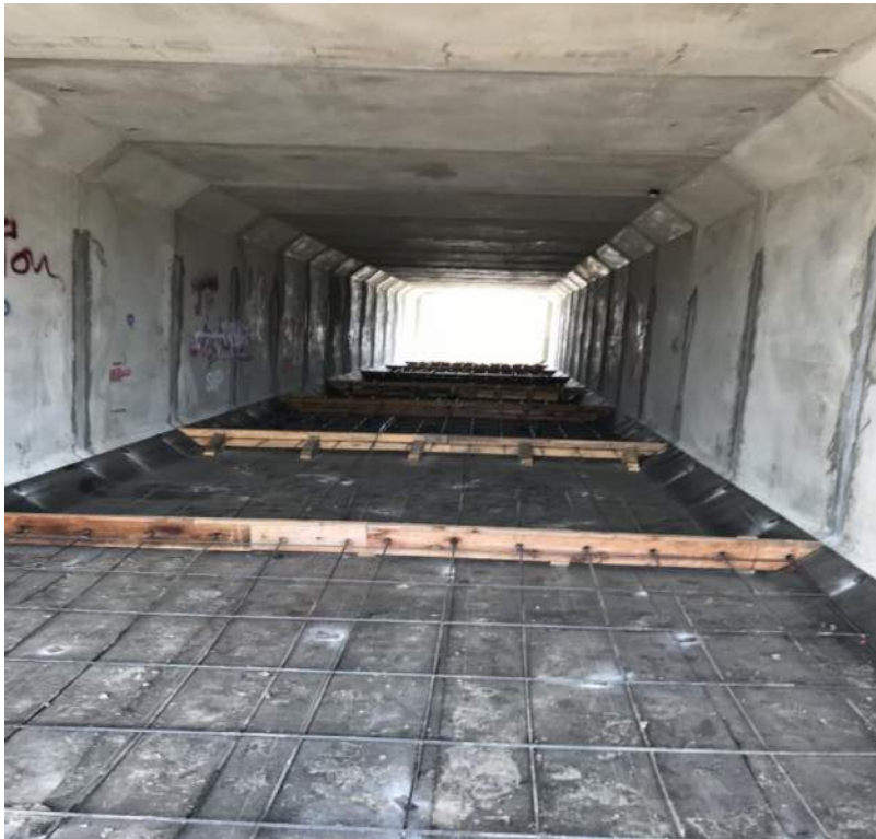
Setting forms for tunnel sidewalk pour
